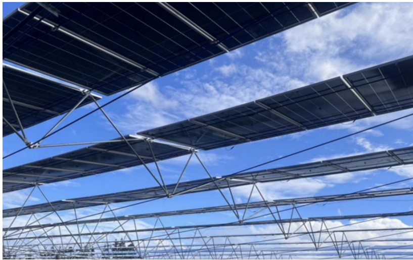
图 2-1 柔性支架安装方式
